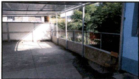
Foto 3: INSTALACIÓN DE LÁMINA TROQUELADA ALUZINC
