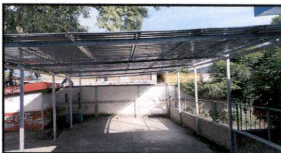
Foto 6: INSTALACIÓN DE LÁMINA TROQUELADA ALUZINC
