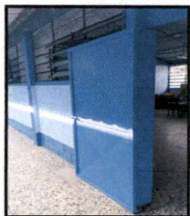
Foto 5: MANTENIMIENTO A ESTRUCTURA DE METAL (LIJADO, CEPILLADO, LIMPIADO Y APLICACIÓN DE PINTURA).
