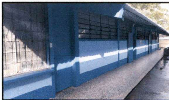
Foto 2: PINTURA EN MUROS EXTERIORES E INTERIORES
