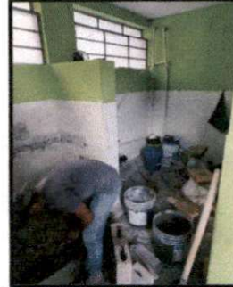
Foto 2: SERVICIOS SANITARIOS Y SUS ACCESORIOS. SUSTITUCIÓN DE 03 SANITARIOS, 02 LAVAMANOS CON SUS ACCESORIOS; REMODELACIÓN EN EL ÁREA DE LAVAMANOS CON PISO CERÁMICO. INSTALACIÓN DE INODOROS, LAVAMANOS, CHORROS, ETC.
