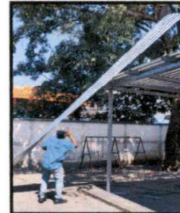
Foto 6: INSTALACIÓN DE LÁMINA TROQUELADA ALUZINC
