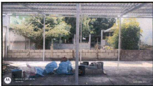
Foto 5: INSTALACIÓN DE LÁMINA TROQUELADA ALUZINC
