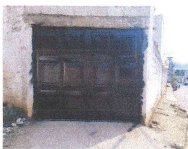
Foto 5: Sustitución de portón de acceso a la cancha deportiva que se encuentra sobre 2da. Avenida de la zona 4.
