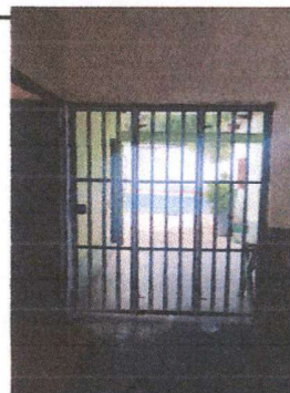
Foto 4: Ampliación y Sustitución de puerta por puerta de reja en el pasillo de acceso a la cancha.
