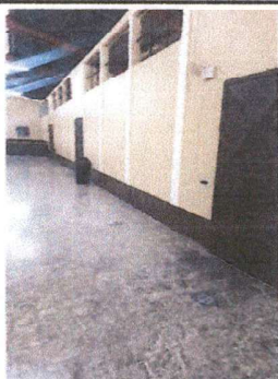
Foto 3: Aplicación de pintura en las paredes interiores del pasillo principal del establecimiento educativo.
