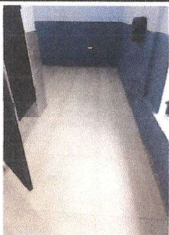
Foto1: Instalación de piso porcelanato en el área de servicios sanitarios.
