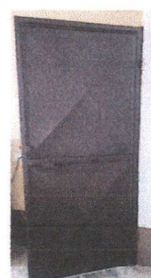
Foto 6: Mantenimiento de pintura a estructura de puertas de metal.
