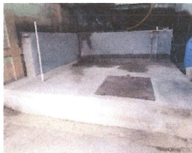
Foto 2: Reparación y remodelación del tanque de captación de agua (cisterna).
