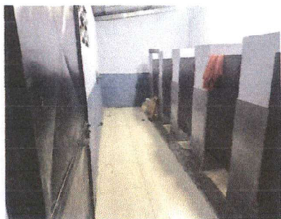
Foto 1: Instalación de piso porcelanato en el área de servicios sanitarios.
