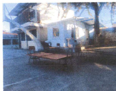
Foto 6: Mantenimiento de pintura a estructura de puertas de metal.
