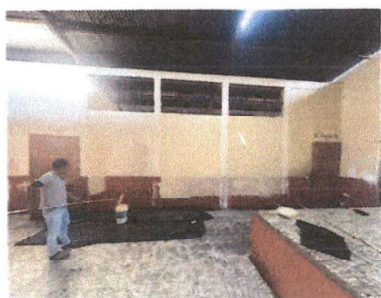
Foto 3: Aplicación de pintura en las paredes interiores del pasillo principal del establecimiento educativo.
