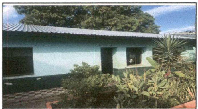
Foto 4: SUSTITUCIÓN DE LÁMINA POR LÁMINA TROQUELADA CALIBRE 26
