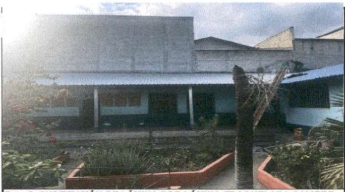
Foto 5: SUSTITUCIÓN DE LÁMINA POR LÁMINA TROQUELADA CALIBRE 26
