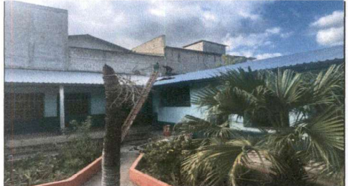
Foto 2: SUSTITUCIÓN DE LÁMINA POR LÁMINA TROQUELADA CALIBRE 26
