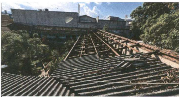
Foto 5: DESINTALACIÓN DE MADERA Y DURALITA
