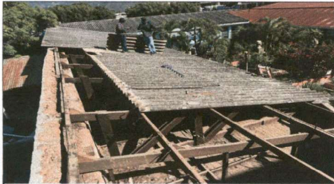
Foto1: DESINTALACIÓN DE TECHO DE LAS AULAS DE SEXTO, PRIMERO.
