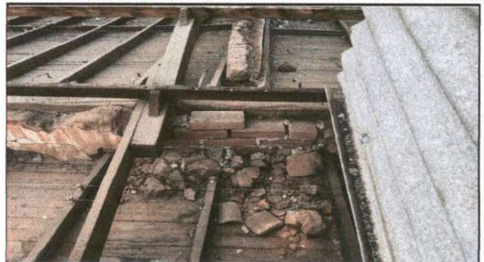
Foto 2: DESINTALACIÓN DE TECHO SEXTO GRADO
