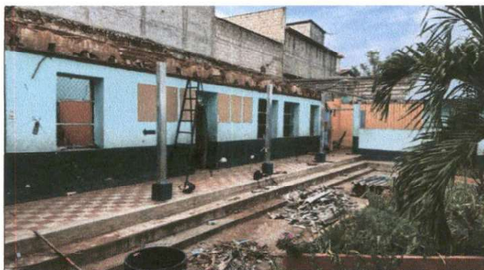
Foto 4: INSTALACIÓN DE COSTANERA DE METAL
