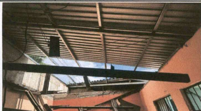
Foto 1: INSTALACIÓN DE LÁMINA TROQUELADA
