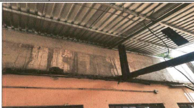
Foto 2: INSTALACIÓN LÁMINA TROQUELADA
