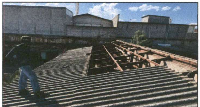
Foto 4: Desintalación de techo de duralita
