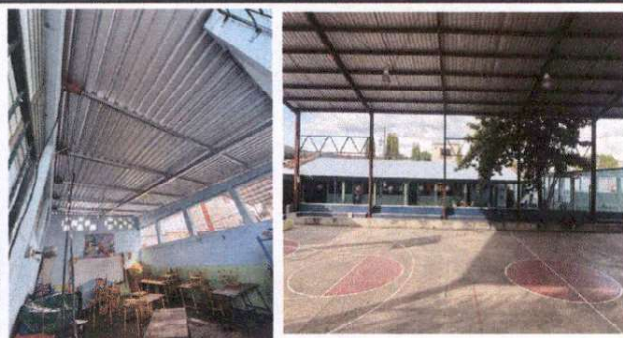
Foto 1: Sustitución de lamina de duralita por lámina troquelada
