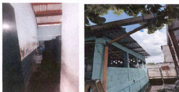
Foto 5: Sustitución de tubería pluvial
