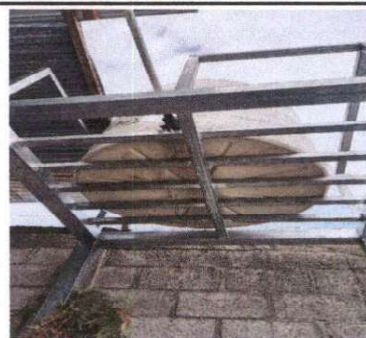
Foto 4: Sustitución de deposito de Agua
