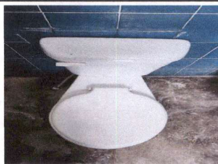
Foto 2: Sustitución de inodoro en mal estado
