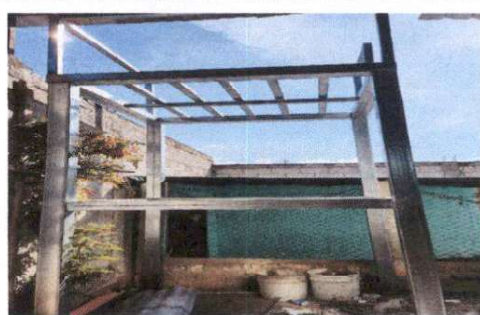
Foto 6: Instalación de estructura de metal para base de depósito de agua
