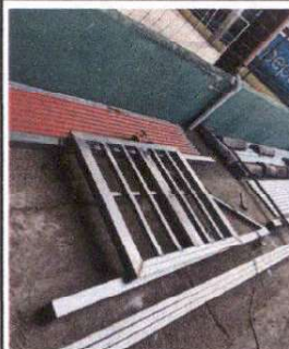
Foto 6: Instalación de estructura de metal para base de depósito de agua
