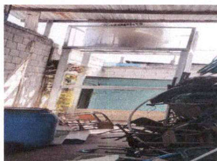
Foto 4: Sustitución de deposito de Agua
