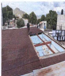
Foto 1: Sustitución de lamina de duralita por lámina troquelada
