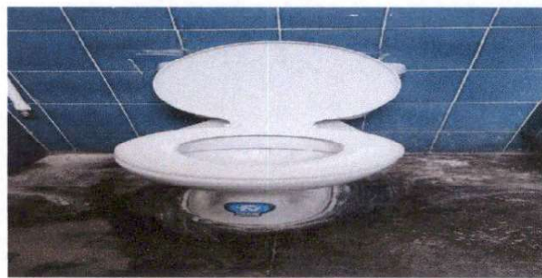
Foto 2: Sustitución de inodoro en mal estado
