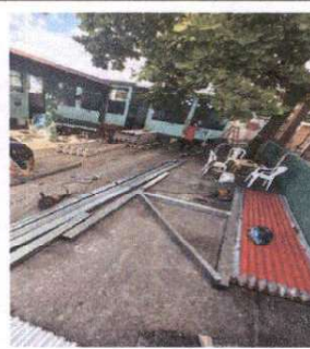
Foto 6: Instalación de estructura de metal para base de depósito de agua
