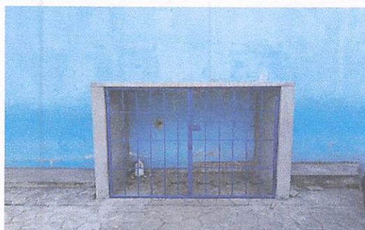
Foto 15: Elaboración de caseta para cilindros de gas
