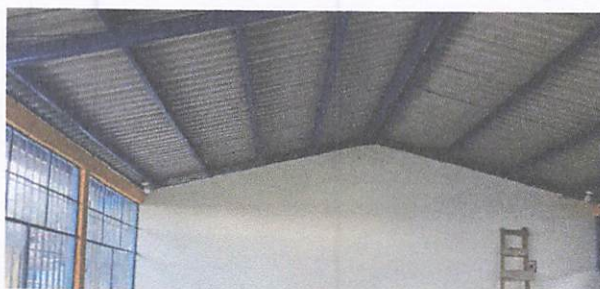
Foto 5: Retirada de cielo falso
