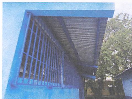
Foto 2: Remozamiento de balcones
