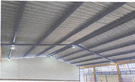
Foto 11: Cambio de acometida electrica, quitado de cableado, instalación de nuevo cableado, instalaciones de luz y tomacorrientes.
