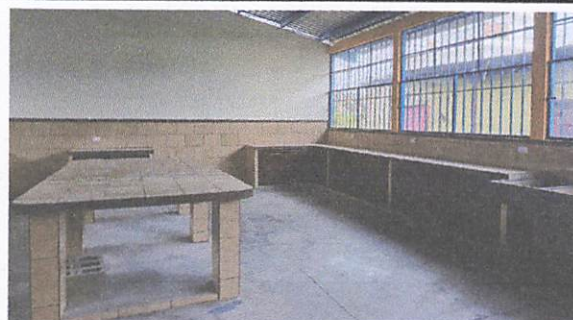
Foto 6: Armado, fundición, tallado y azulejado de fonda de cocina con entrepaño y banca
