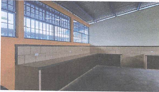
Foto 7: Armado, fundición, tallado y azulejado de top de cocina con entrepaño y banca
