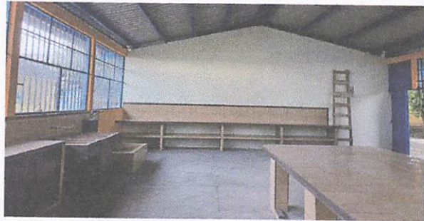
Foto 8: Armado, fundición, tallado y azulejado de top de cocina con entrepaño y banca
