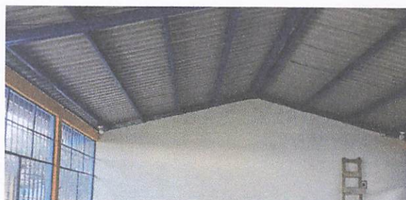
Foto 4: Retirada de electromalla
