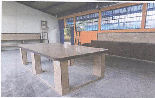
Foto 9: Armado, fundición, tallado de isla de cocina
