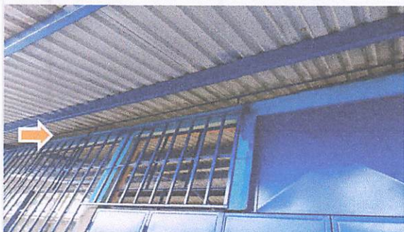
Foto 13: Instalación de ventanal de cedazo
