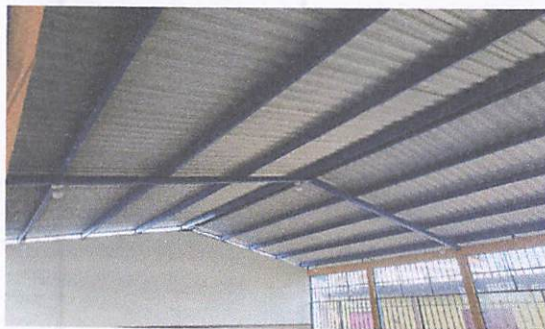
Foto 1: Remozamiento de costaneras.
