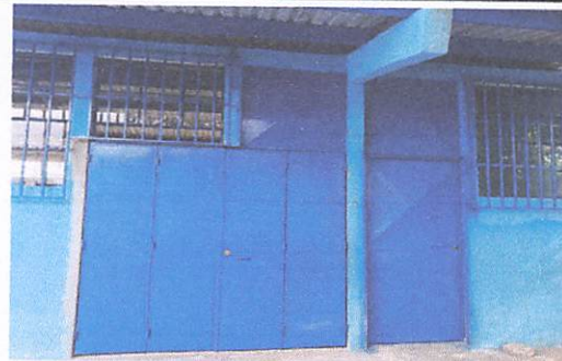
Foto 12: Elaboración e instalación de portón de 4 hojas.
