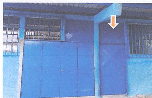
Foto 14: Remozamiento de puertas
