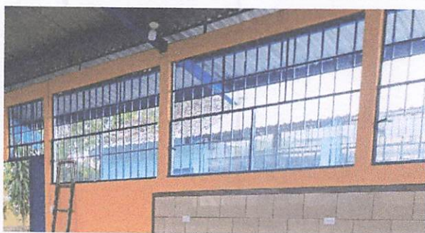
Foto 3: Limpieza de vidrios
