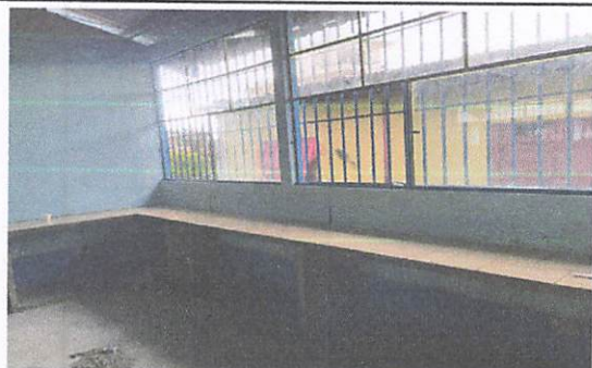
Foto 9: Armado, fundición, tallado y azulejado de top de cocina con entrepaño y banca
