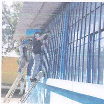
Foto 3: Limpieza de vidrios
