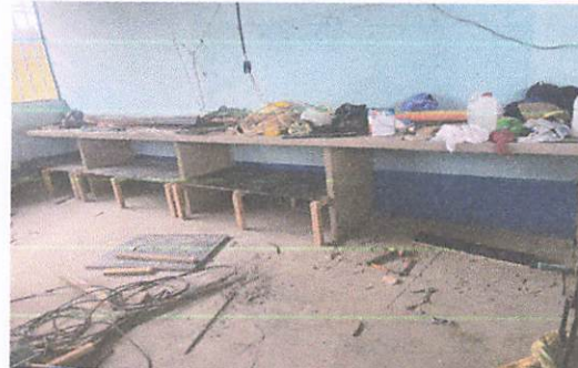
Foto 8: Armado, fundición, tallado y azulejado de top de cocina con entrepaño y banca
