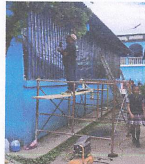
Foto 2: Remozamiento de balcones
