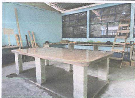
Foto 11: Armado, fundición, tallado de isla de cocina
