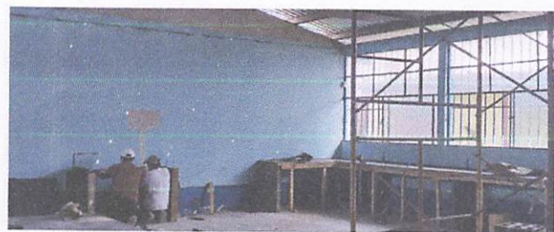
Foto 6: Armado, fundición, tallado y azulejeado de top de cocina con entrepaño y banca
