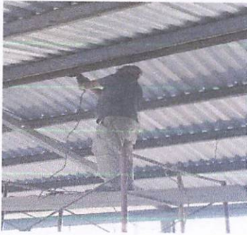
Foto 1: Remozamiento de costaneras.
