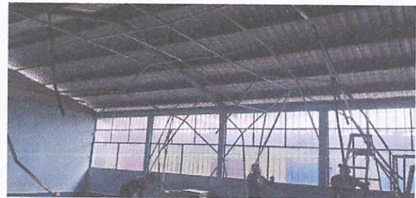
Foto 4: Retirada de electromalla
