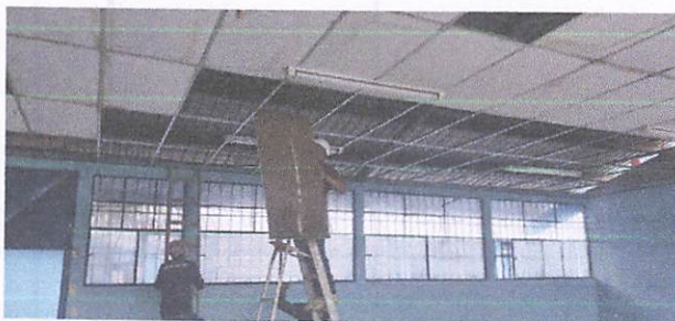
Foto 5: Retirada de cielo falso
