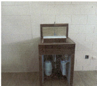
Foto 5: Implementación de mueble para filtro y colocación de filtro para agua.
