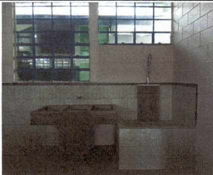
Foto 3: modificación de ventanal, colocación de pila, implementación de drenaje y agua potable e implementación de lava ollas.
