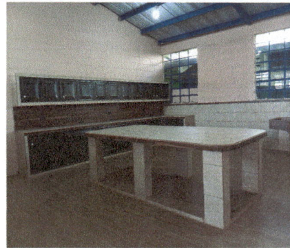
Foto 2: Implementación de isla de concreto, pintura y sustitución de piso de madera
