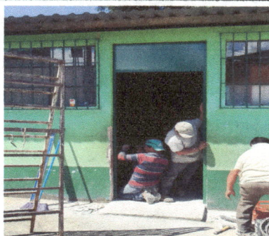
Foto 5: Sustitución de puertas en dos salones
