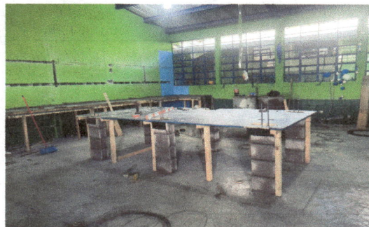
Foto 2: Tallado de isla de concreto y mesa de trabajo
