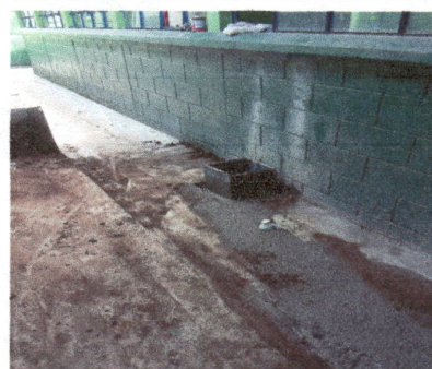
Foto 4: Implementación de drenaje y agua potable para pila y lava ollas de la cocina
