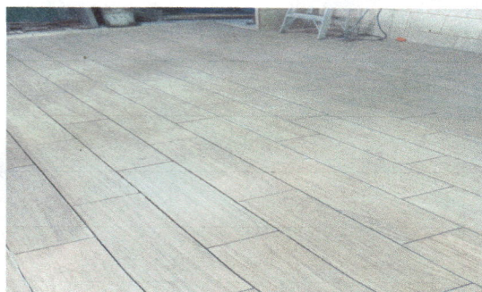
Foto 3: Sustitución de piso
