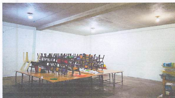
Foto 3: IMPERMEABILIZACIÓN DE INTERIOR DE LAS AULAS
