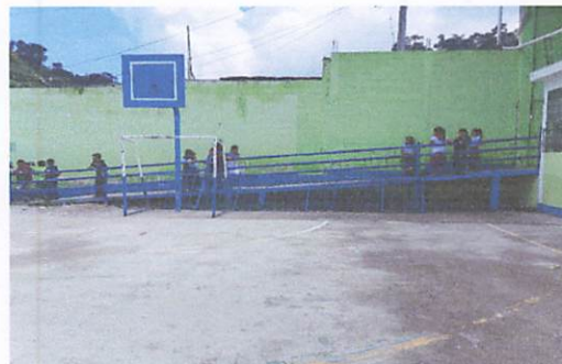
Foto 2: MANTENIMIENTO DE BARANDA DE SEGURIDAD
