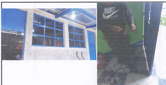
Foto 6: CAMBIO DE CHAPAS Y ELABORACIÓN DE VENTANAS
