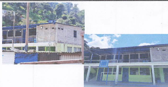
Foto 4: COLOCACIÓN DE TECHO EN LOS 3 MODULOS
