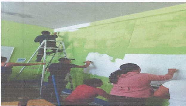
Foto 3: IMPERMEABILIZACIÓN DE INTERIOR DE LAS AULAS
