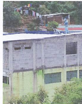
Foto 4: COLOCACIÓN DE TECHO EN LOS 3 MODULOS
