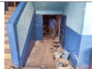
Foto 1 Suministro e instalación de puerta de metal de 100cm x 114 cm.
