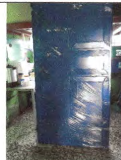
Foto 1 Suministro e instalación de puerta de metal de 100cm x 114 cm.
