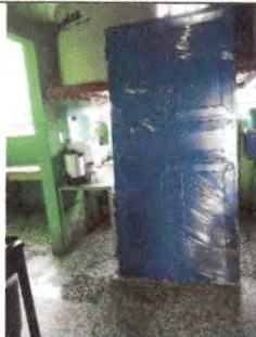
Foto 1 Suministro e instalación de puerta de metal de 100cm x 114 cm.
