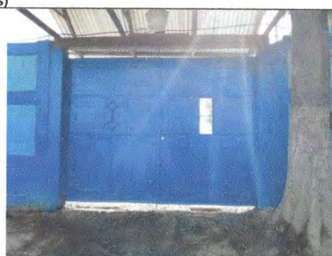
Foto 2 Sustitución de un portón principal de 2.96x2.30 mts. (Mantenimiento a portones)
