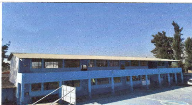
Foto1 Pintura de techo exterior (Cubierta de laminas)
