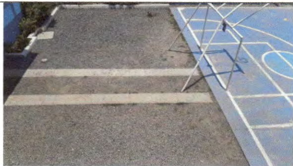
Foto 1 Fundición de losa en patio veinticinco metros cuadrados (Losa de patio)
