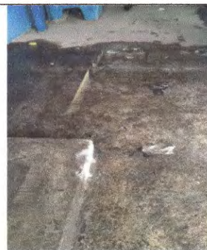
Foto 2 Colocación de piso treinta y seis metros cuadrados (piso)
