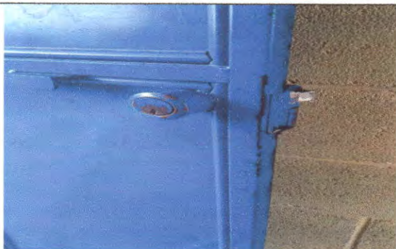
Foto 1 Cambio de 3 chapas (Puertas)
