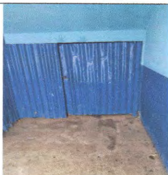
Foto 1 Colocación puertas de acceso (Puertas)
