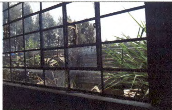
Foto 2 Colocación vidrios (Ventanas)
