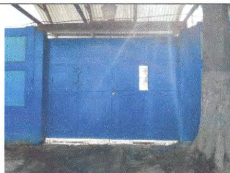
Foto 2 Elaboración de una cuneta en entrada (Cunetas de concreto)
