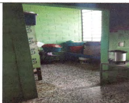
Foto 2 Colocación puertas de acceso (Puertas)
