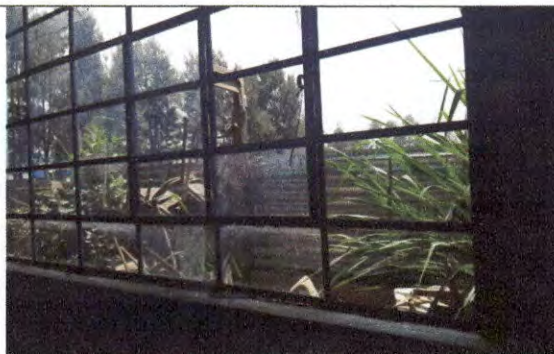
Foto 1 Colocación vidrios (Ventanas)
