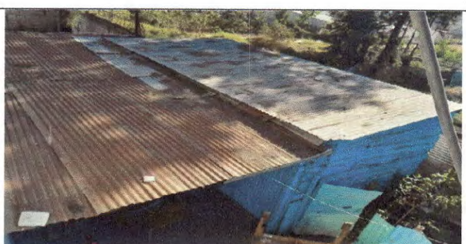
Foto 2 Sustitución de costaneras de 4 x 4 pulgadas para columnas (Estructura de techo)
