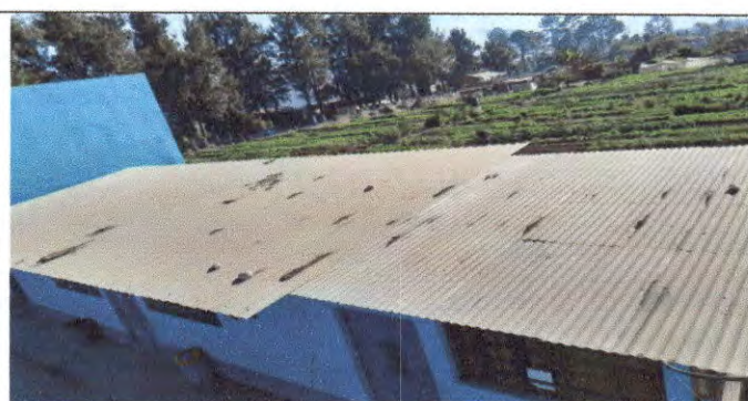
Foto 2 Pintura de techo exterior (Cubierta de laminas)
