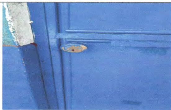
Foto 2 Cambio de 3 chapas (Puertas)
