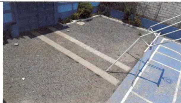
Foto 2 Fundición de losa en patio veinticinco metros cuadrados (Losa de patio)
