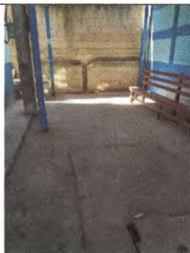
Foto 1 Colocación de piso treinta y seis metros cuadrados (piso)
