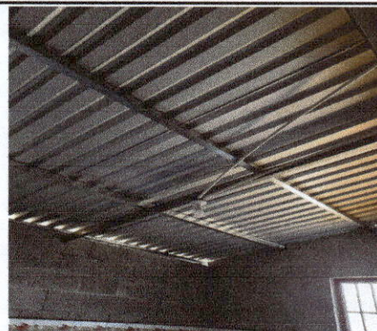
Foto 2: TECHADO FINAL EN AMPLIACION DE COCINA
