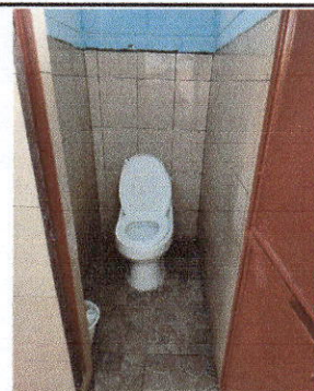
Foto 6: INSTALACION DE SANITARIOS Y COLOCACION DE AZULEJOS
