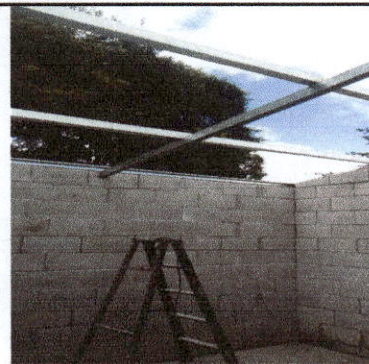
Foto 2: COLOCACION TECHADO A AMPLIACION DE COCINA
