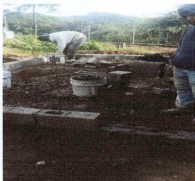
Foto 1: AMPLIACION DE COCINA CON MANO DE OBRA DE ALCALDE MUNICIPAL
