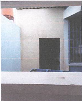
Foto 2: en la parte de afuera se colocó la pila y se agregó al drenaje.
