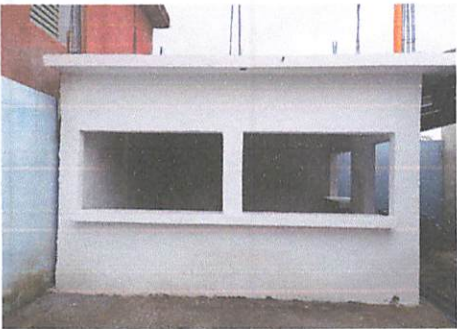
Foto 3: se hizo un espacio alterno y externo para cocina.
