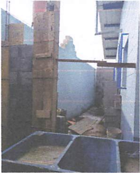
Foto 2: Levantado de pared para almacen de cocina.
