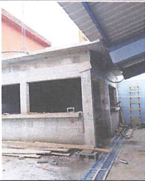
Foto 4: Losa sacada para su repello.
