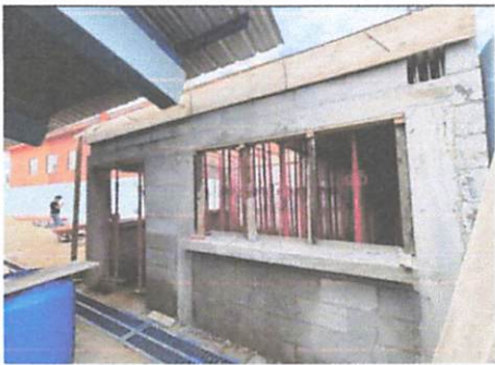
Foto1: Armado de tarima para fundicion de losa.
