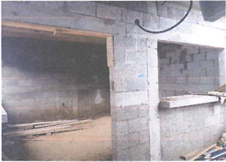
Foto 5: levantado finalizado de pared.
