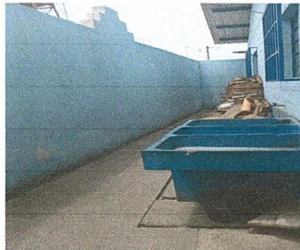
Foto 2: FUGA DE AGUA QUE OCASIONA ENFERMEDADES
