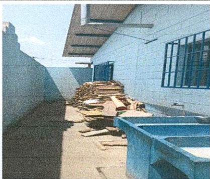
Foto 5: Existe falta de un lugar para almacenar leña y los alimentos, hay necesidad de ampliar la cocina.
