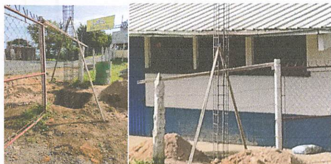
Foto 1: Construcción de acometida eléctrica de acometida eléctrica
