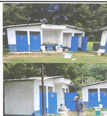
Foto 4: desinstalación de inodoros en mal estado e instalación de inodoros nuevos
