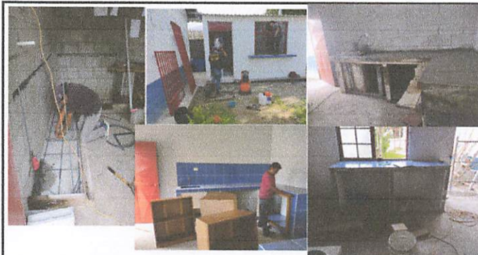
Foto 2: Repello interior, instalación de puertas de rejas, construcción de mesón y 1 lavaplatos, colocación de azulejo, e instalación de mueble aéreo para cocina.
