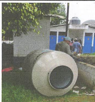
Foto 5: Desinstalación de tinacos en mal estado e instalación de tinacos nuevos
