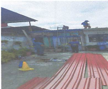
Foto 3: colocacion de lamina en cocina
