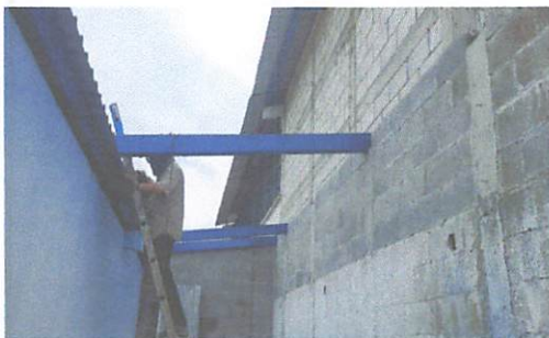
Foto 5: colocacion de costaneras y techo para bodega y direccion
