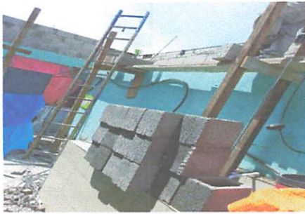
Foto 1: colocacion de ilada de block en la cocina
