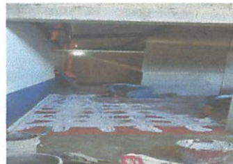
Foto 6: colocacion de piso para direccion
