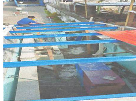
Foto 2: colocacion de costaneras y cambio de lámina para cocina.
