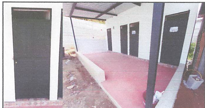
Foto 6: Puertas reparadas y patio extendido.
