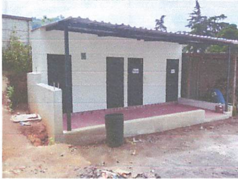
Foto1: Ampliación de corredor para los sanitarios.
