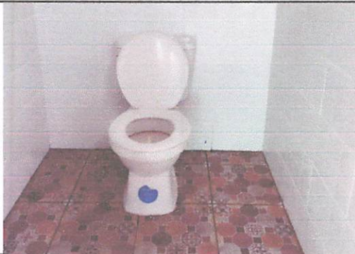
Foto 3: Sanitario, azulejo y cerámico cambiado
