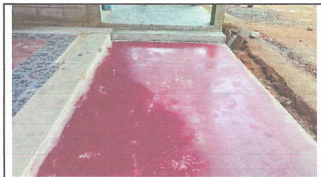
Foto 4: Corredor de comedor con grada.
