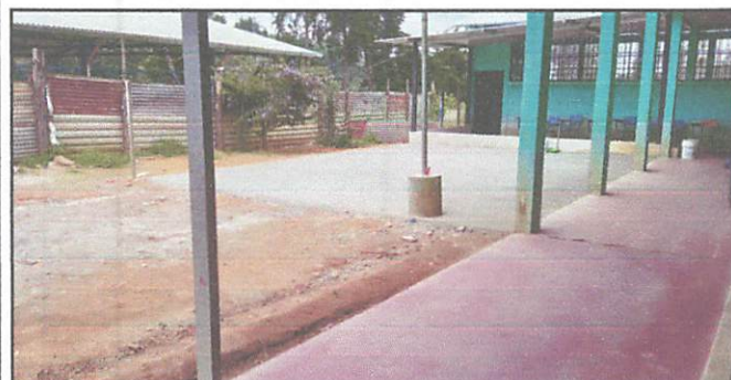
Foto 5: Patio de aproximadamente 48mts fundido normal.
