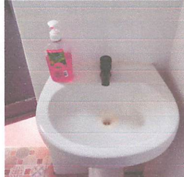
Foto 2: Lavamanos adaptado de forma individual a los sanitarios.
