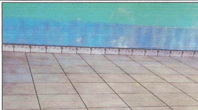
Foto 2: Piso y zócalo
