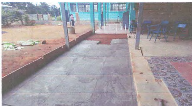
Foto 3: Torta de patio para comedor en fundición.
