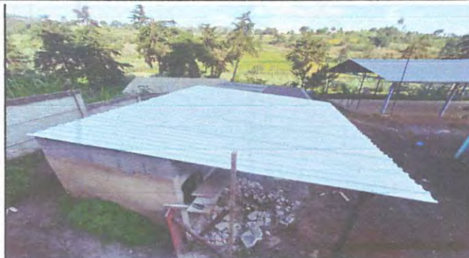
Foto 1: análisis de la cantidad de tierra a extraer a un costado del sanitario.
