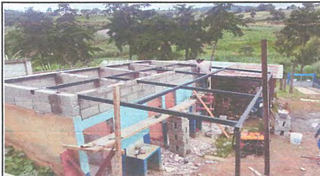
Foto 2: Re ubicación de la estructura metálica para techo.
