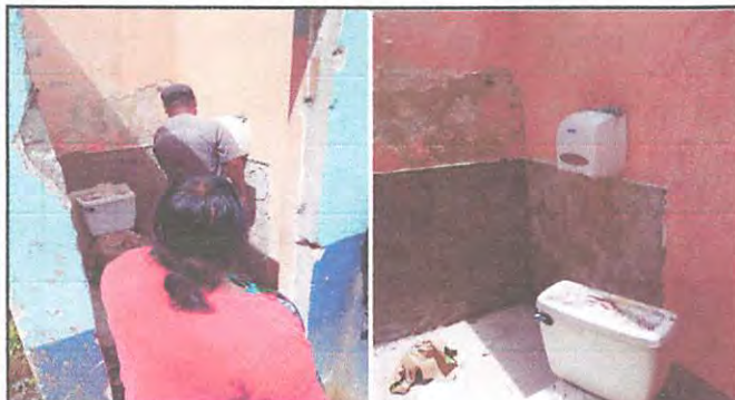
Foto 3: Extracción de cernido y, cerámico y sanitarios.
