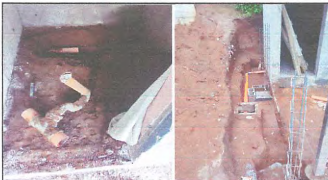
Foto 4: Cambios de tubería interna y externa
