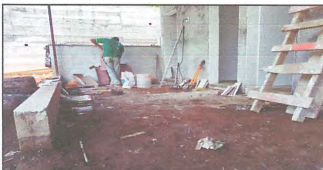
Foto 6: Nivelación de tierra y preparación para aplicar torta de patio para sanitarios.
