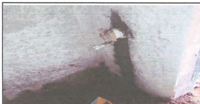
Foto 6: Tubería de lavamanos inexistente y por ende existencia de fugas de agua.
