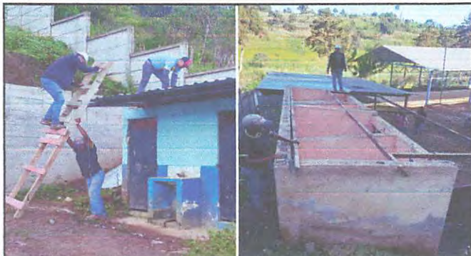
Foto1: Extracción de toda la parte de herrería
