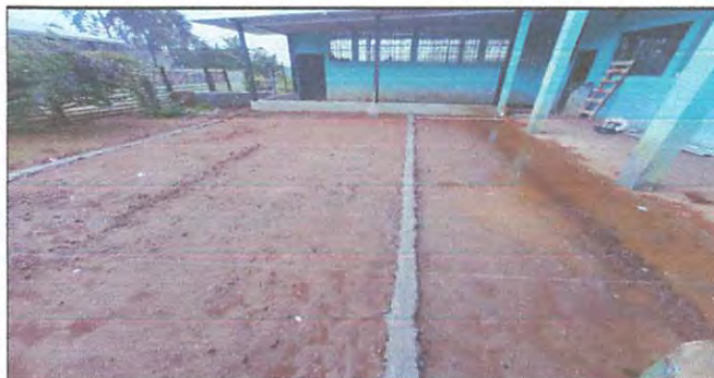
Foto 6: preparación del terreno para la fundición de la torta de patio.
