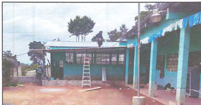
Foto 5: Levantado de techado y bordillo así como la torta.
