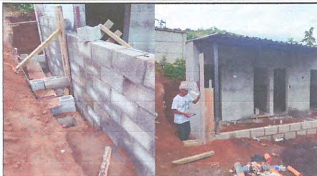
Foto 2: Cimentación levantado y aplicación de mono capa para el muro de refuerzo perimetral.
