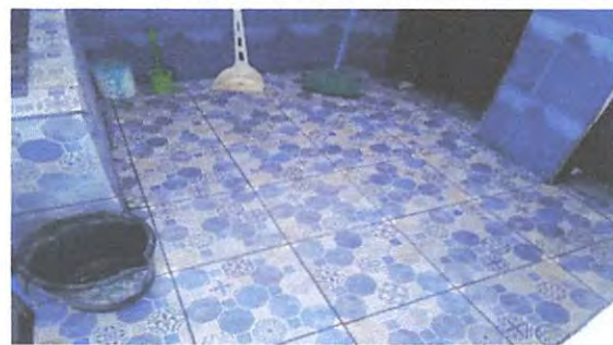
Foto 4: COLOCACIÓN DE CERAMICO EN SANITARIOS
