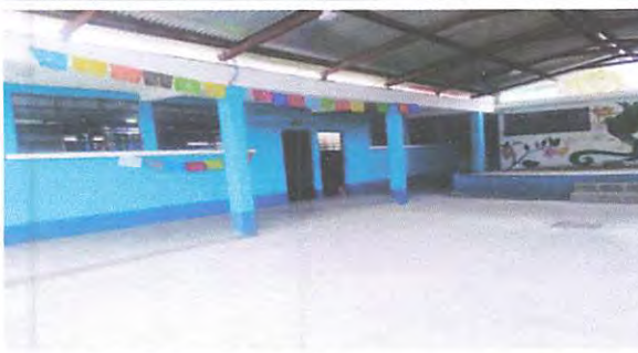
Foto 3: PINTADA DEL CORREDOR
