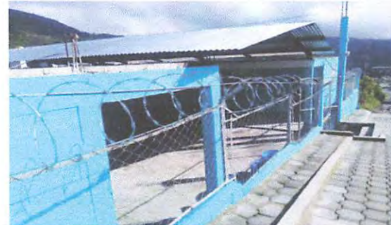
Foto 2 AREA PERIMETRAL FRONTAL ALAMBRE PUA
