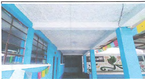
Foto 5: PINTADA DEL CIELO DEL EDIFICIO
