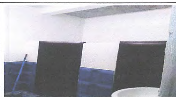
Foto 5: COLOCACIÓN DE PUERTAS EN SANITARIOS
