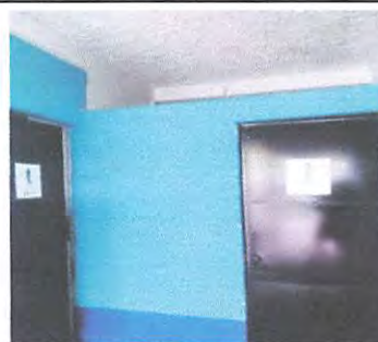
Foto 6: COLOCACION DE PUERTAS EN SANITARIOS
