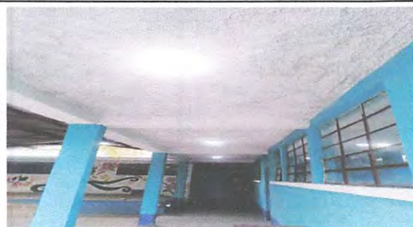
Foto 1: ENERGIA ELECTRICA CORREDOR
