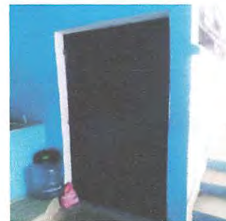
Foto 4 COLOCACION PUERTA EN COCINA
