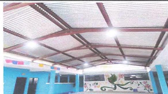
Foto 2: ENERGIA ELECTRICA EN SALON DE USOS MULTIPLOS
