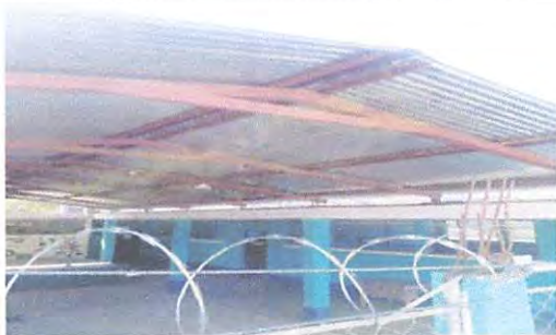
Foto1: COLOCACION DE ALAMBRE DE PUAS
