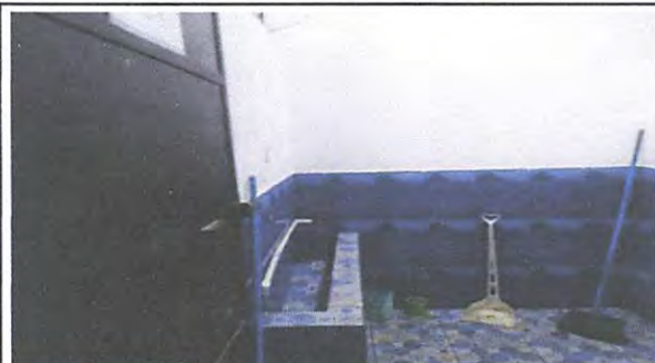
Foto 2: COLOCACIÓN DE AZULEJOS EN SANITARIOS
