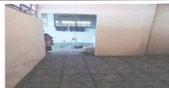
Foto 5: REPELLO, CERNIDO Y PISO CERAMICO EN COCINA
