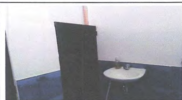
Foto 3: COLOCACIÓN DE LAVAMANOS EN SANITARIOS
