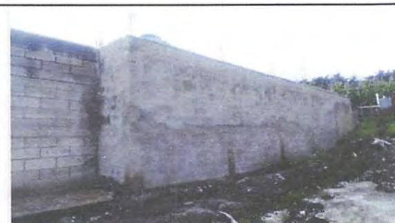
Foto 3: PARED DE COCINA
