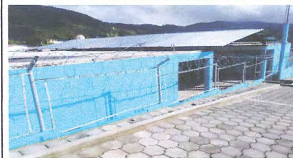
Foto 4 PINTADO GENERAL DEL EDIFICIO EDUCATIVO
