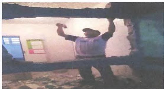
Foto1: DEMOLICION DE PARED DE LA COCINA
