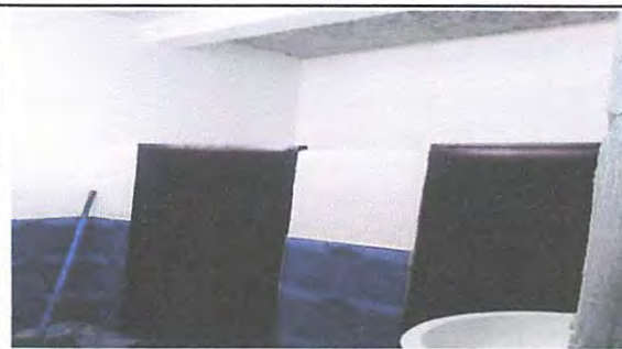
Foto 6: COLOCACIÓN DE PUERTAS Y ACCESORIOS
