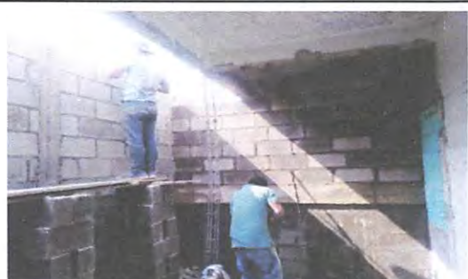
Foto 3: LEVANTADO DE PARED LADO INTERIOR DE LA COCINA
