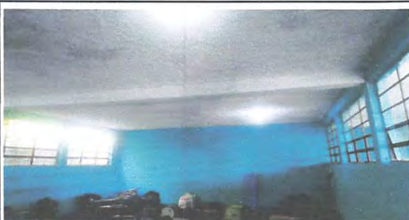
Foto 3: REPARACION DE ENERGIA EN SALON DE CLASES
