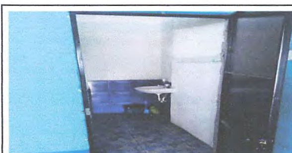
Foto: 6 COLOCACION PUERTA EN ENTRADA DE SANITARIO
