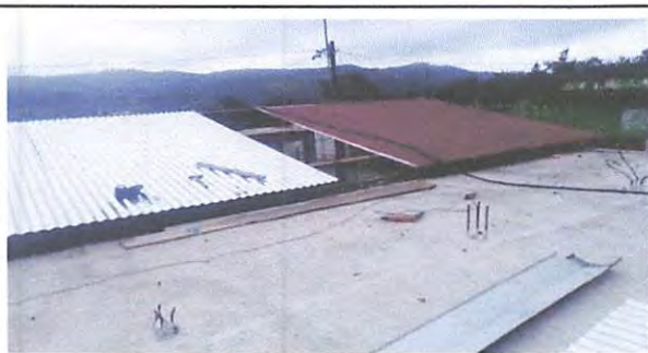
Foto 3: CAMBIO DE LAMINAS LADO DERECHO
