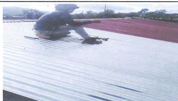
Foto 2: CAMBIO DE LAMINAS
