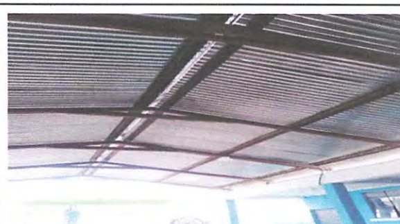
Foto 4 COLOCACION DE LAMINAS NUEVAS
