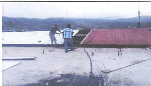
Foto1: DESMANTELAR LAMINAS
