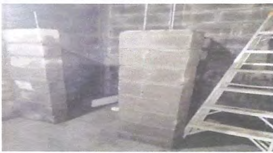
Foto 3: DIVISION DE BLOK EN LOS SANITARIOS
