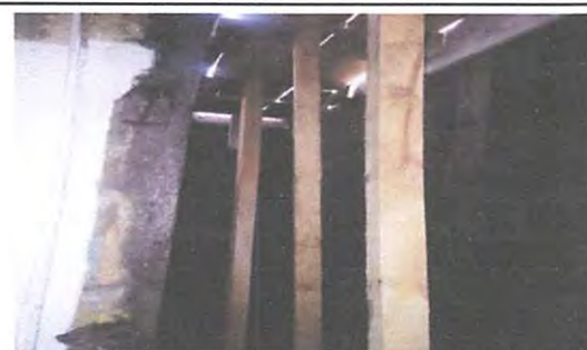
Foto 5: COLOCACION DE PARALES PARA LA HECHURA DE LA COCINA
