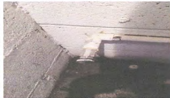
Foto 2: COLOCACIÓN TUBERIA DE AGUA EN SANITARIOS
