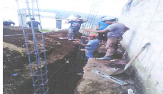
Foto 2 EXCAVACION DE ZANJA Y CIMIENTO DE PARED LA COCINA
