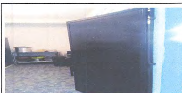
Foto 5: COLOCACION PUERTA EN COCINA
