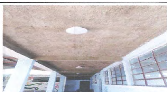
Foto 5: REPARACION Y CAMBIO DE FOCOS EN CORREDOR
