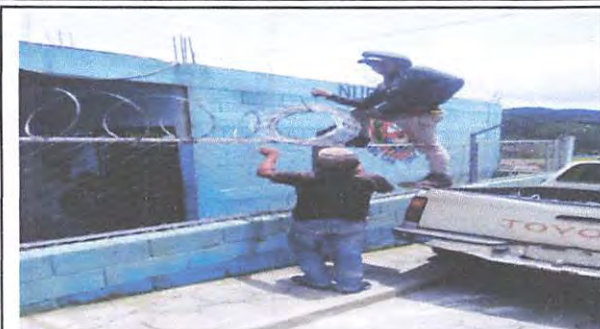
Foto 1: COLOCACION DE AL DE PUAS
