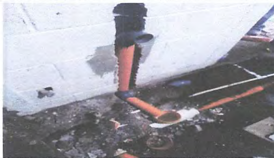
Foto 1: COLOCACIÓN DE DRENAJE EN SANITARIOS
