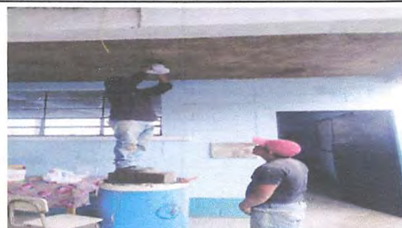
Foto 1: REVISION DE FOCOS Y CAMBIO EN CORREDOR
