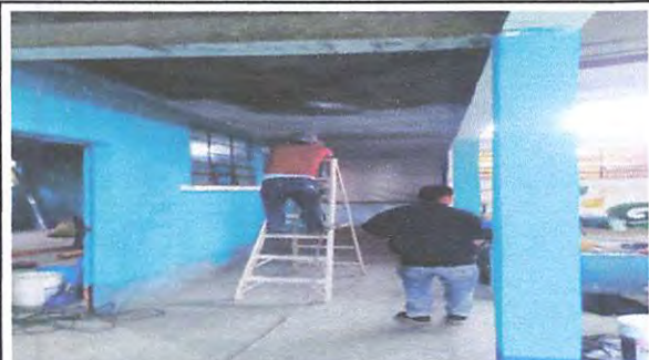
Foto1: PINTADA DEL CIELO DEL CORREDOR
