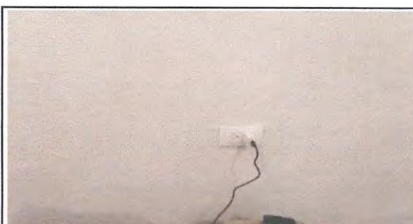
Foto 6: REPARACIÓN DE ENERGIA ELÉCTRICA, LABORATORIO DE COMPUTACION
