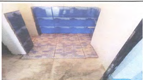
Foto 5: COLOCACIÓN DE AZULEJO Y CERAMICO EN SANITARIOS
