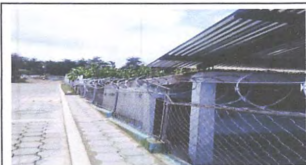
Foto 3 COLOCACION ALAMBRE PUA LADO IZQUIERDO
