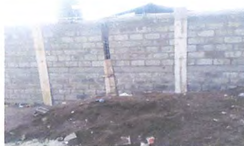
Foto 4 LEVANTADO DE PARED LADO DE LA CALLE
