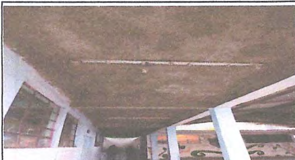
Foto 1: REPARACION ENERGIA ELECTRICA CORREDOR
