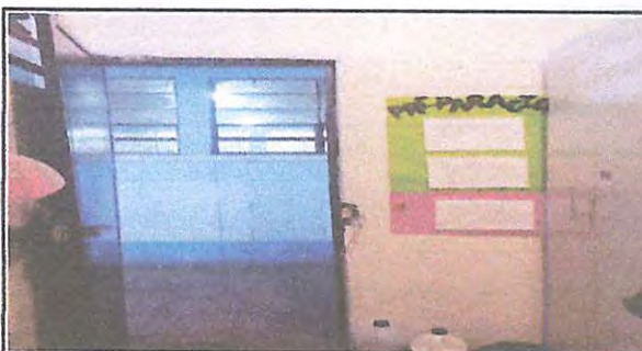
Foto 6: COLOCACION DE PUERTA.
