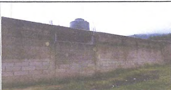
Foto 1: AMPLIACIÓN Y MEJORAMIENTO DE COCINA HACER PARED
