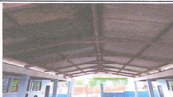
Foto 2: CAMBIO DE LAMINAS
