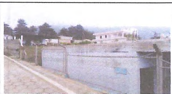
Foto 5: COLOCACIÓN DE ALAMBRE DE PUAS
