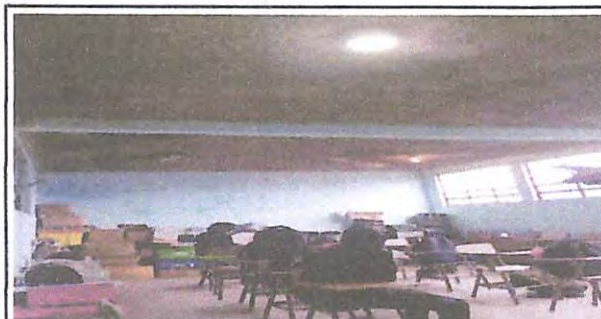
Foto 5: REPARACION DE SALON DE CLASES
