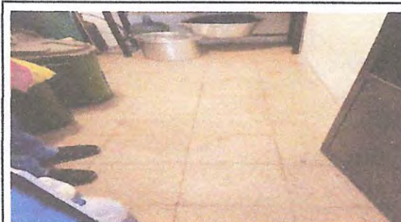
Foto 4: COLOCACION DE PISO CERAMICO
