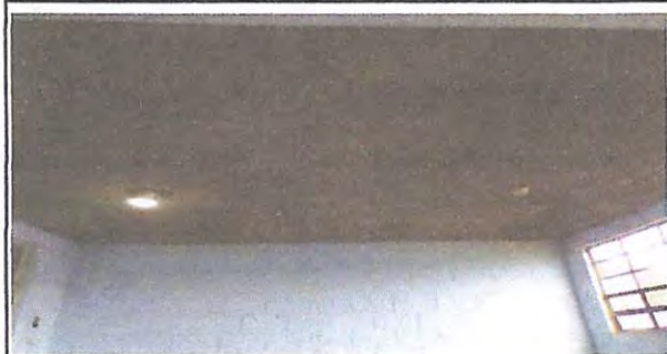
Foto 3: REPARACION SALON DE CLASES
