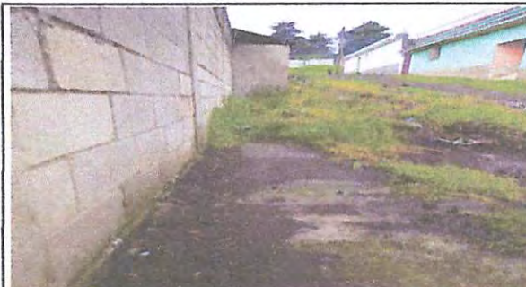
Foto 2: AMPLIACION COCINA, DEMOLER PARED Y HACER TERRAZA
