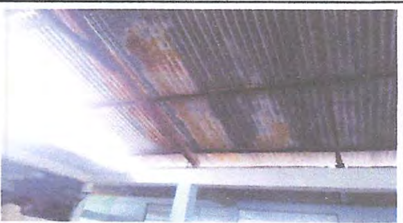
Foto 3: CAMBIO DE TECHADO DEL SALÓN
