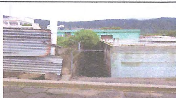
Foto 1: COLOCACION DE ALAMBRE DE PUAS
