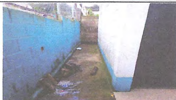
Foto 2 PINTADA PARED PERIMETRAL
