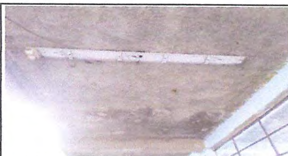
Foto 6: REPARACIÓN DE ENERGÍA ELÉCTRICA, LABORATORIO DE COMPUTACION.
