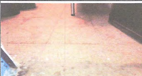
Foto 3: CAMBIO DE PISO
