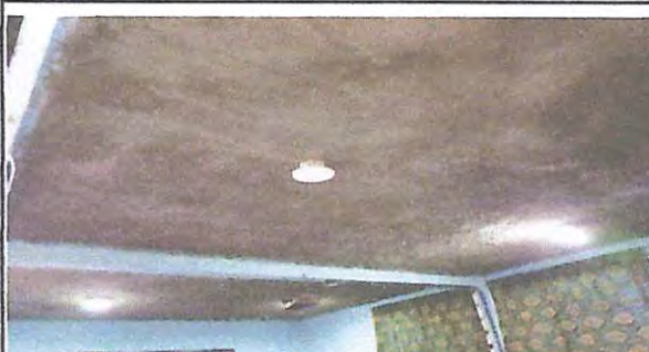
Foto 4 REPARACION DE SALON DE CLASES
