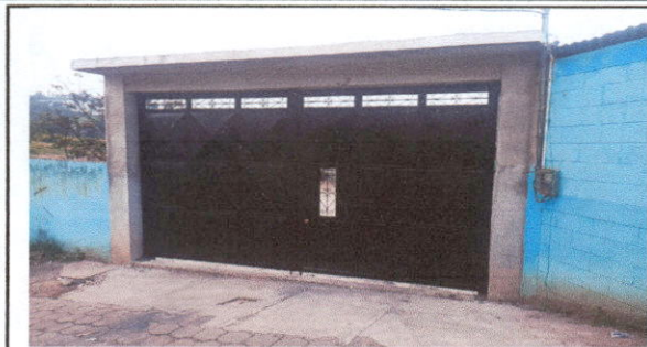
Foto1: Cambio de porton.
