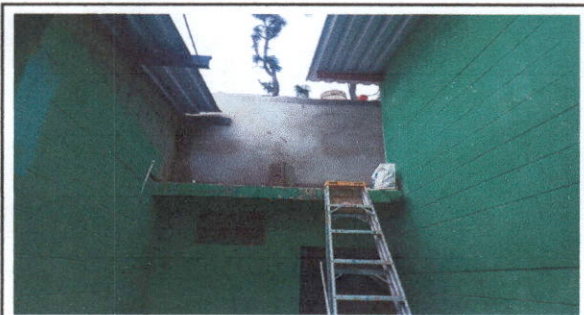
Foto 4: Construcción de depósito.
