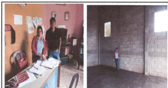
Foto 5: Supervisión y muro perimetral.
