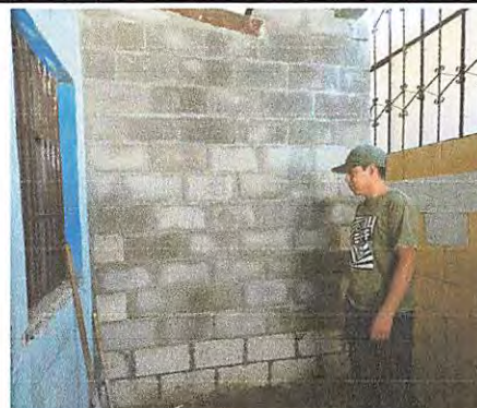
FINALIZACION DE LEVANTADO DE MURO
