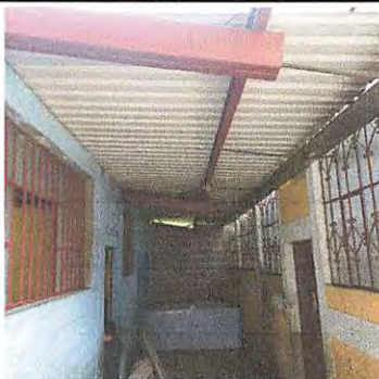
FINALIZACION DE MANTENIMIENTO DE TENDAL
