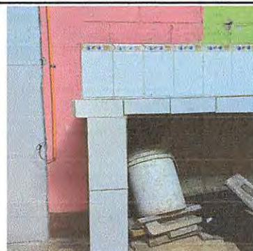
FINALIZACION DEL CORTE DE TOP DE COCINA
