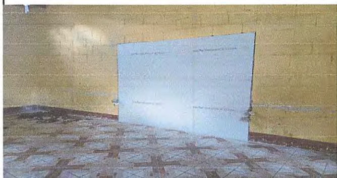
FINALIZACION DE COLOCACION DE TABLA YESO
