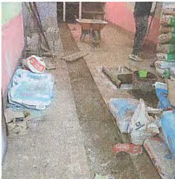
FINALIZACION DE LA COLOCACION DE TUBOS DE DRENAJE Y AGUA POTABLE
