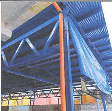
FINALIZACION DE INSTALACION DE BAJADAS DE AGUA
