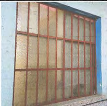
FINALIZACION DE MANTENIMIENTO DE VENTANAS
