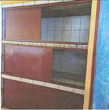
FINALIZACION DE ELABORACION DE GABINETE DE COCINA
