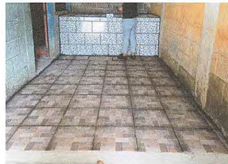
FINALIZACION DE COLOCACION DE PISO EN EL AREA DE AMPLIACION DE CORREDOR
