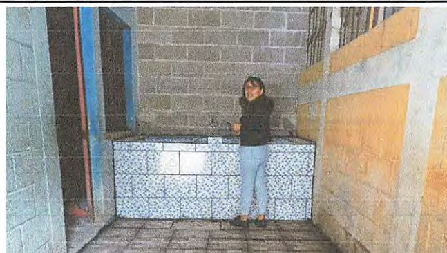
FINALIZACIÓN DE ELABORACION DE PILA
