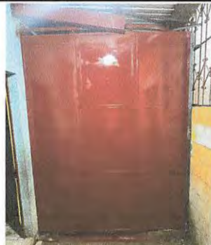
FINALIZACION DE INSTALACION DE PUERTA CORREDIZA
