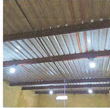
FINALIZACION DE INSTALACION DE LUZ EN AULAS, BODEGAS Y COCINA, HACIENDO UN TOTAL DE 10 FOCOS.
