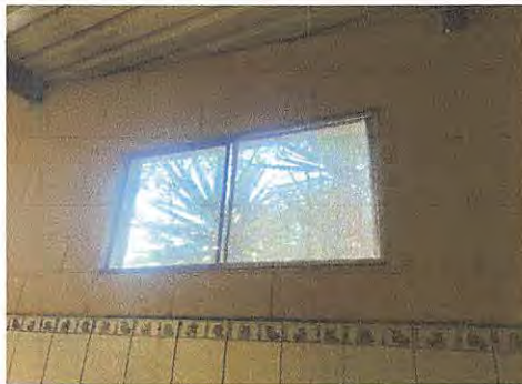
FINALIZACION DE COLOCACION DE VENTANAS
