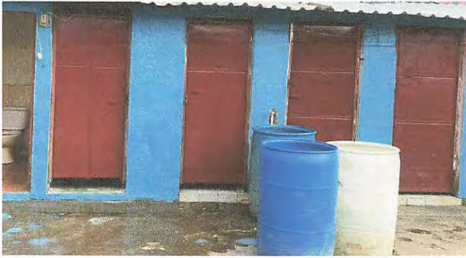
FINALIZACION DE MANTENIMIENTO DE PUERTAS DE BAÑOS
