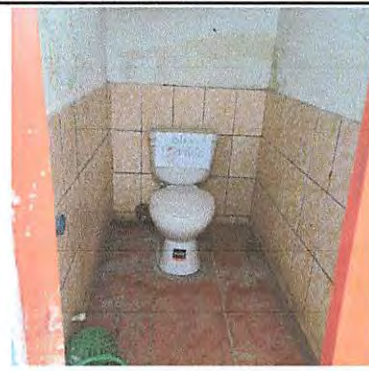
FINALIZACION DE INSTALACION DE UN SANITARIO
