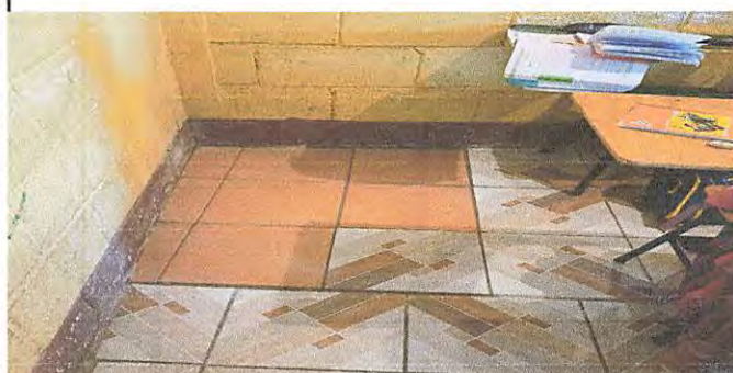
FINALIZACION DE COLOCACION DE PISO
