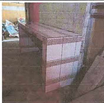
FINALIZACION DE ELABORACION DE TOP DE COCINA
