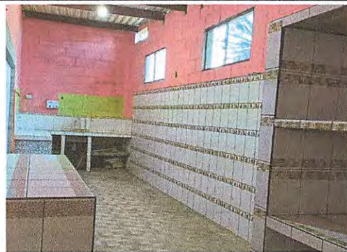
FINALIZACION DE COLOCACION DE AZUEJOS EN COCINA
