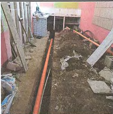
PROCESO DE INSTALACION DE DRENAJE Y TUBOS DE AGUA POTABLE
