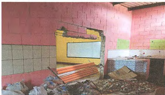
DEMOLICION DE PARED ENTRE AULA Y COCINA
