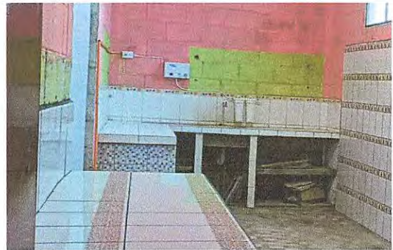
PROCESO DE INSTALACION DE PURIFICADOR DE AGUA POTABLE
