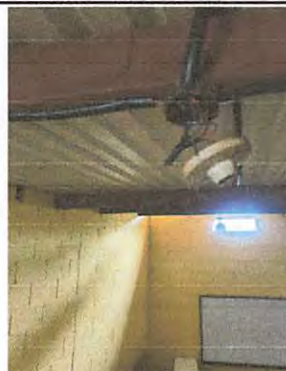
PROCESO DE INSTALACION DE LUZ, EN AULAS, BODEGA Y COCINA , HACIENDO UN TOTAL DE 10 FOCOS.
