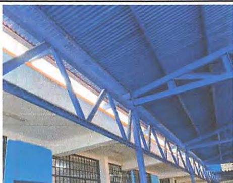
PROCESO DE INSTALACION DE BAJADAS DE AGUA
