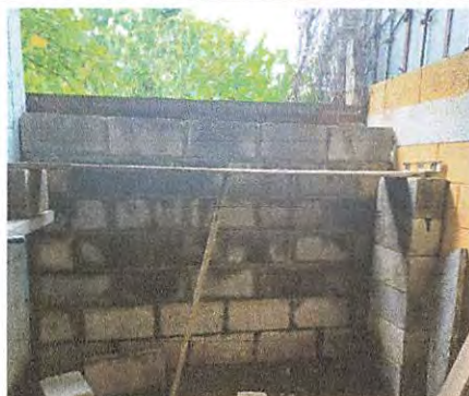
PROCESO DE LEVANTADO DE MURO
