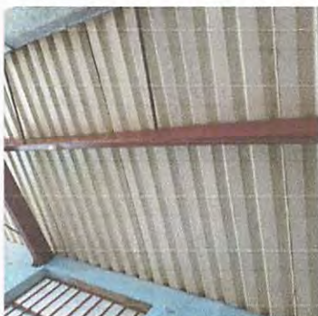
PROCESO DE MANTENIMIENTO DE TENDAL
