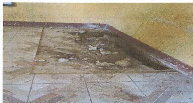
PROCESO DE LEVANTADO DE PISO
