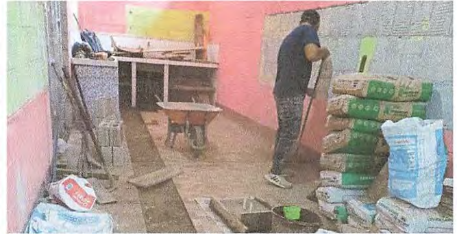
PROCESO DE ELIMINACION DE AZULEJO EXISTENTE
