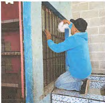
PROCESO DE MANTENIMIENTO DE VENTANAS
