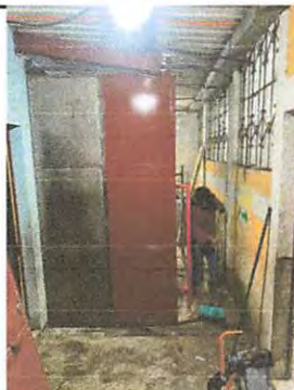
PROCESO DE INSTALACION DE PUERTA CORREDIZA
