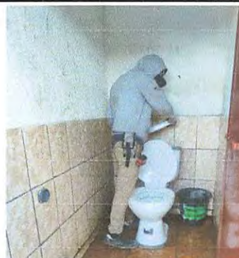
PROCESO DE INSTALACION DE UN SANITARIO
