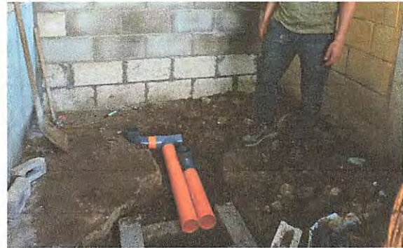
PROCESO DE COLOCACION DE PISO
