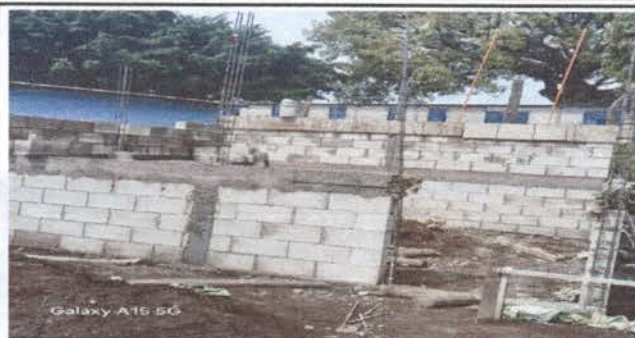
foto 1: Mejoramiento de paredes
