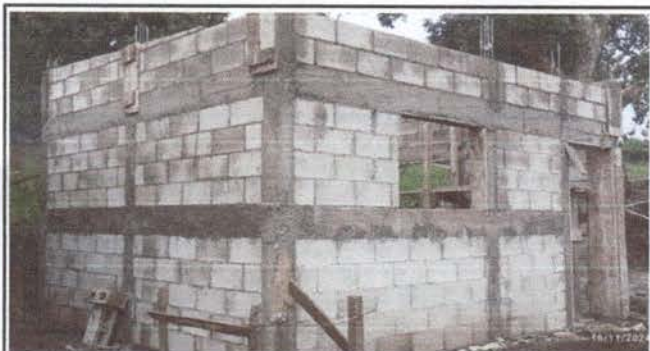
Foto 3: Estructura física preparada para el techo
