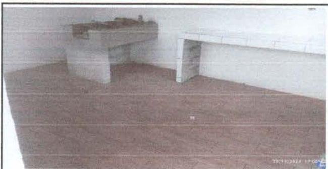
Foto 5: Estructura interna con plancha de cocinar.
