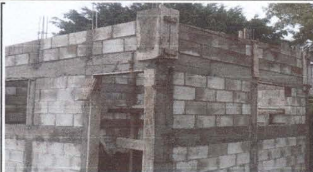
Foto 2: Fueron reforzadas con columnas más sólidas.
