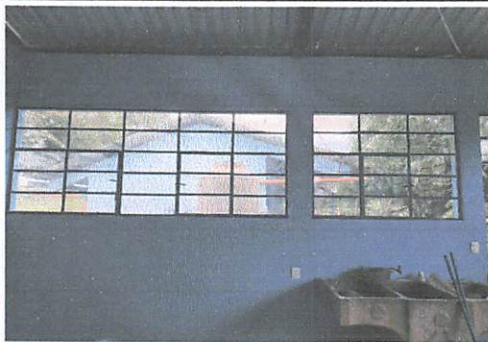
Foto 3: Colocación de ventanas
