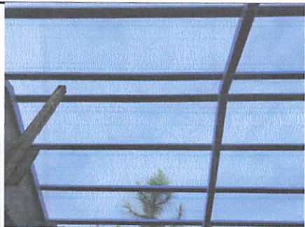
Foto 5: colocación de costaneras
