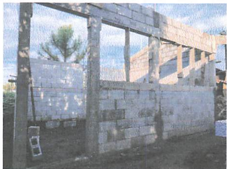
Foto 1: levantado de bloques
