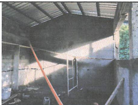
Foto 6: techo de cocina
