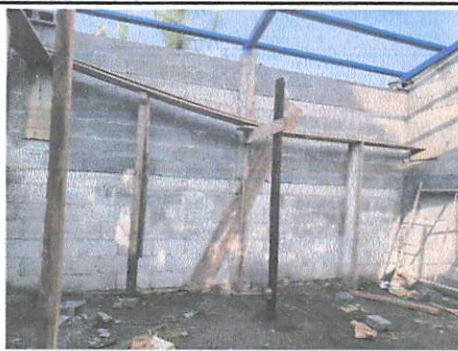
Foto 4: Estructura de techo
