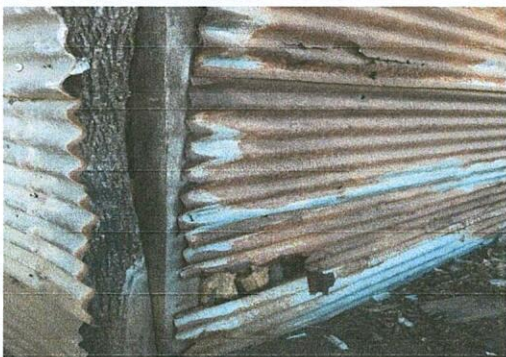
Foto 3: Cosina en mal estado
