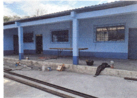
Foto 2: Pintado de edificio escolar
