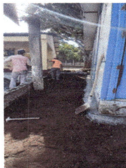
Foto 2: pavimento para el campo
