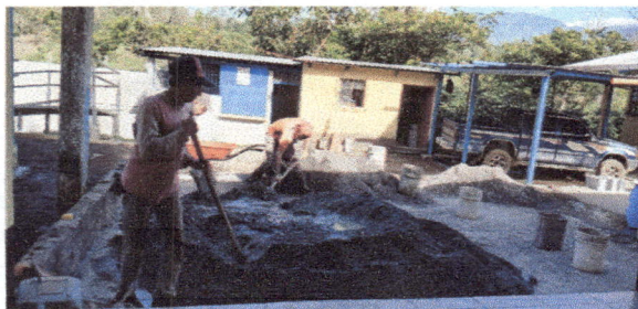
Foto 4: reparación de patio frente a bodega
