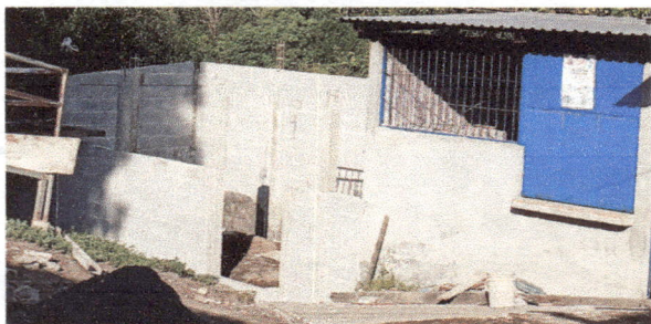
FOTO 5: Levantado de muro de comedor
