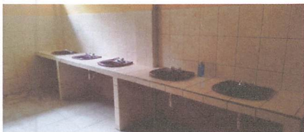
Foto 3: REPARACIÓN DE ACCESORIOS PARA LAVAMANOS
