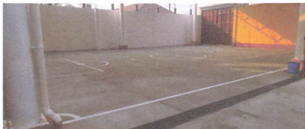
Foto 1: CAMBIO DE PISO DE CONCRETO EN PATIO DE CENTRO EDUCATIVO
