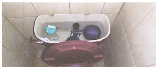
Foto 5: CAMBIO COMPLETO DE ACCESORIOS PARA SANITARIO
