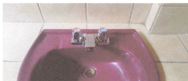
Foto 4: CAMBIO DE LLAVES PARA LAVAMANOS
