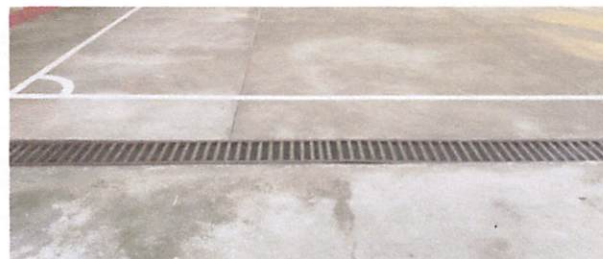
Foto 2: REALIZACIÓN DE CUNETAS PARA EVITAR EL INGRESO DE AGUA AL ÁREA POLIDEPORTIVA O PATIO
