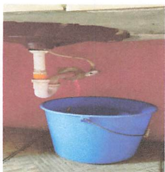
Foto 3: REPARACIÓN DE ACCESORIOS PARA LAVAMANOS
