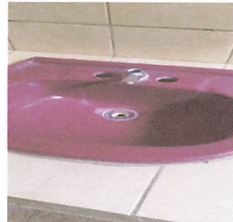
Foto 4: CAMBIO DE LLAVES PARA LAVAMANOS
