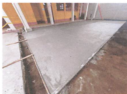
Foto 2: REALIZACIÓN DE CUNETAS PARA EVITAR EL INGRESO DE AGUA AL ÁREA POLIDEPORTIVA O PATIO
