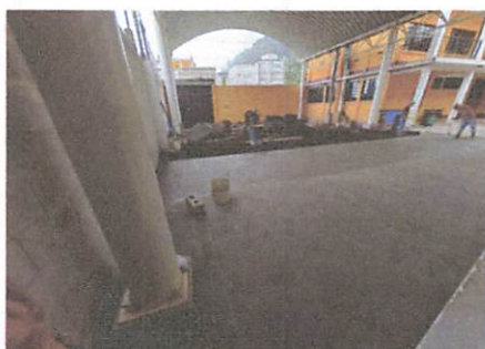
Foto 1: CAMBIO DE PISO DE CONCRETO EN PATIO DE CENTRO EDUCATIVO
