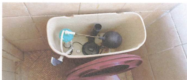
Foto 5: CAMBIO COMPLETO DE ACCESORIOS PARA SANITARIO
