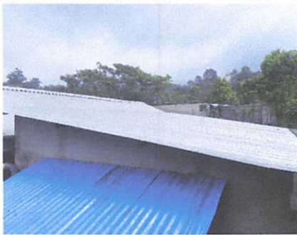
Foto 3: cambio de techo
