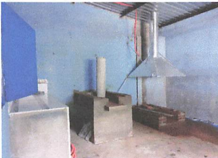
Foto 5: polletones y top de concreto
