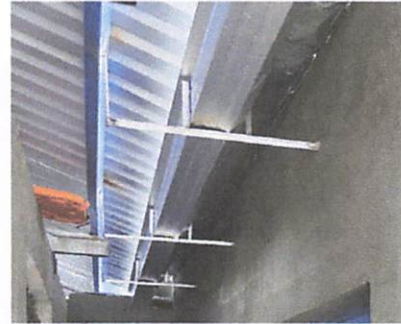
Foto 4: instalación de canales
