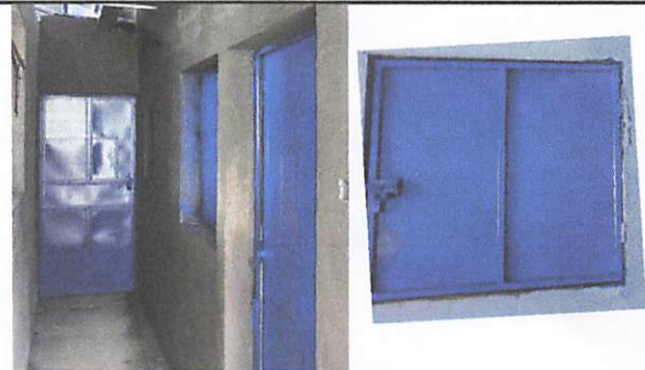
Foto 6: instalación de puertas y ventana
