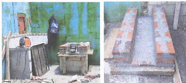
Foto 5: polletones y top de concreto
