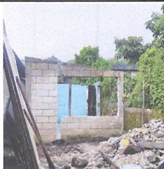
Foto 3: cambio de techo
