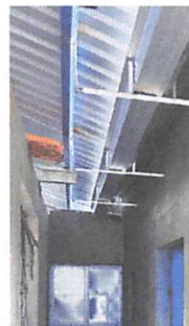
Foto 4: instalación de canales
