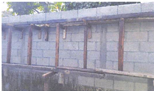
Foto 2: remodelación de cocina, eliminación de muro lateral derecho y agrandado de cocina
