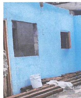
Foto 6: instalación de puertas y ventana
