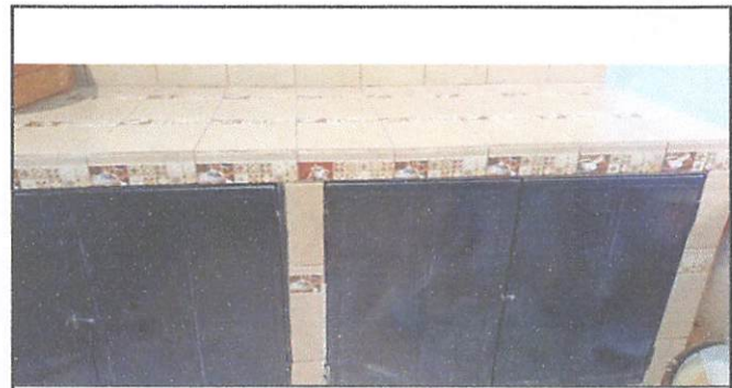
Foto 6: top con azulejo y puertas instaladas.
