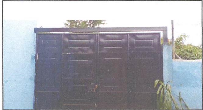
Foto 2: portón principal instalado.
