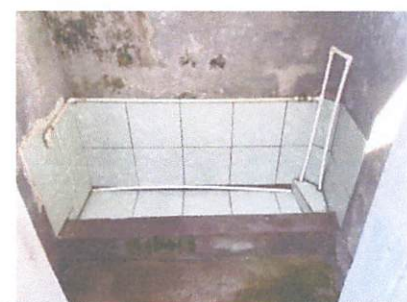
Foto 6: instalación de cerámica en minijótorios.
