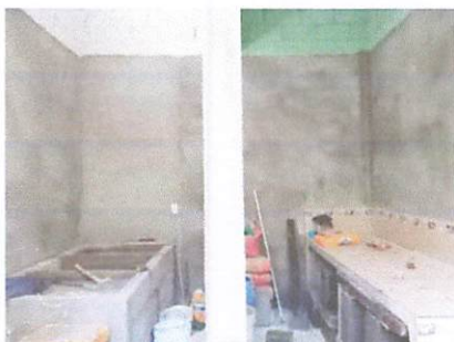
Foto 1: construcción de la pila de concreto y el top dentro de la cocina nueva.
