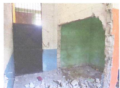
Foto 5: demolición de pared para construcción de cocina.
