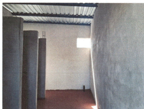
Reparacion de servicios Sanitarios
