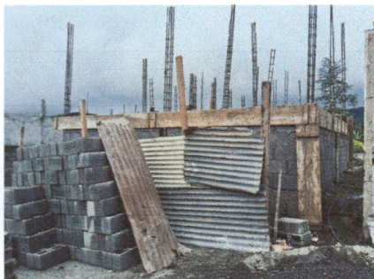
Foto 1: trabajos de repacion de cocina y servicios sanitarios
