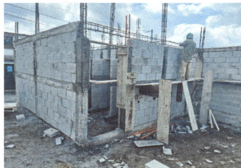
Foto 1: trabajos de repacion de cocina y servicios sanitarios
