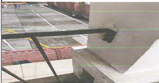
Foto 11: baranda reforzada y pintada en el área de la cancha
