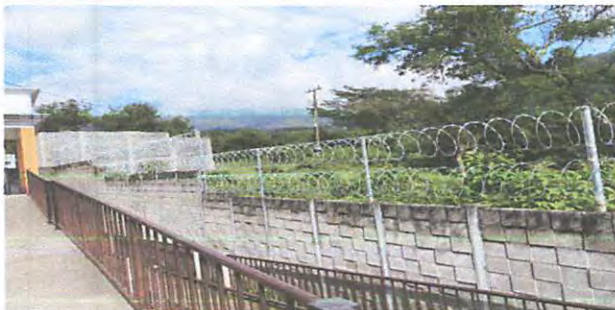
Foto 16: colocación de razor ribbon en muro perimetral
