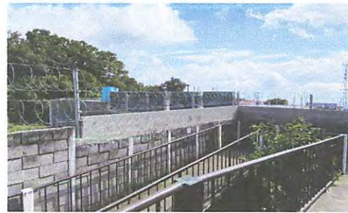
Foto 8: razor ribbon en muro perimetral
