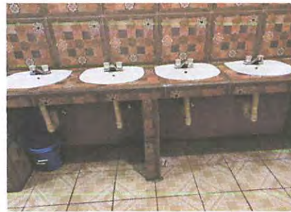
Foto 15: reparación de lavamanos en módulo de sanitarios
