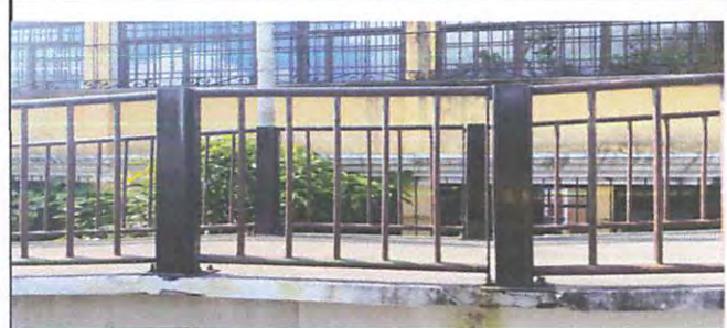
Foto 17: reparación de baranda en área de rampa
