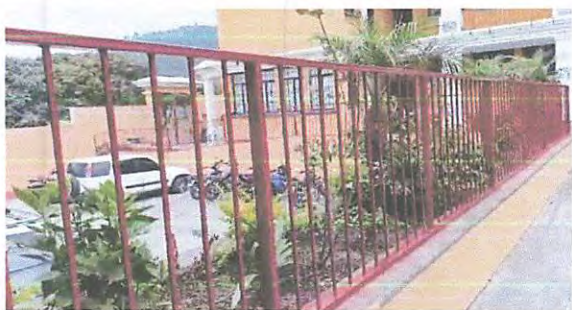
Foto 3: baranda reforzada y pintada en el área de la cancha
