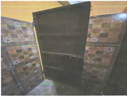
Foto12: colocación de puerta en módulo de sanitario de varones
