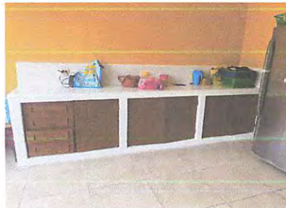
Foto2: top de cocina terminado con puertas y con azulejos
