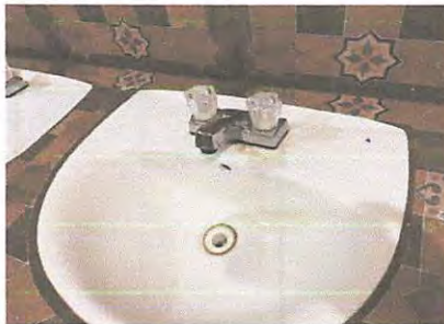
Foto 9: reparación de lavamos, colocación de accesorios
