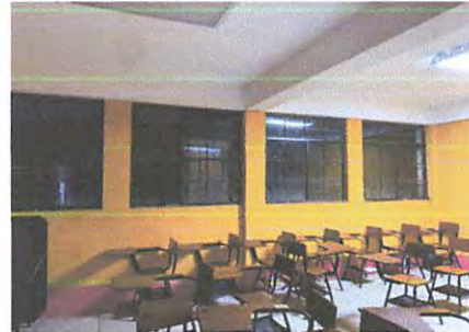
Foto 13: pintura en interiores de salones
