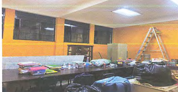
Foto 2: durante el proceso de pintar los salones en las paredes del exterioro
