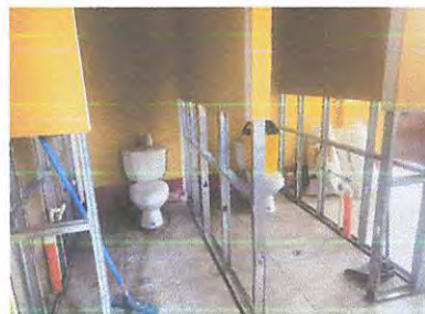
Foto 4: cambio de pared en el módulo de los sanitarios del area de dirección
