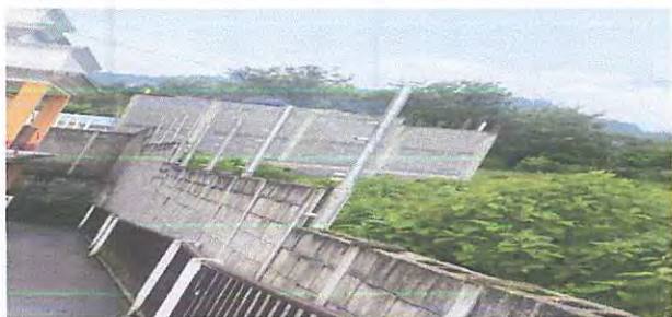
Foto1: en proceso de colocar la malla en el muro perimetral
