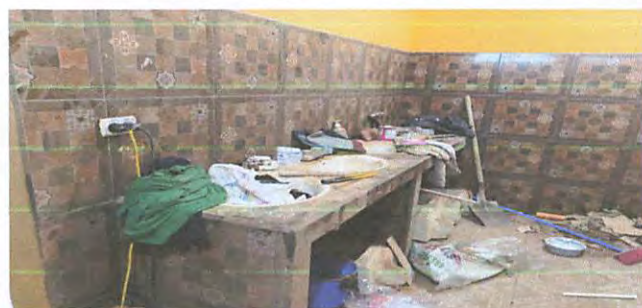
Foto 8: reparacion de lavamanos
