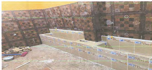
Foto 7: construcción de migitorios ins-situ
