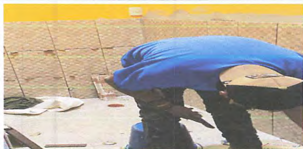
Foto 10: colocación de azulejos en el área de sanitarios
