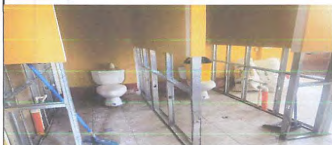
Foto 7: construcción de migitorios ins-situ
