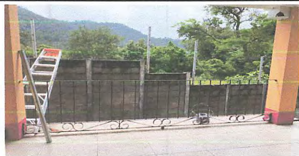
Foto 3: colocación de balcón en el segudo nivel
