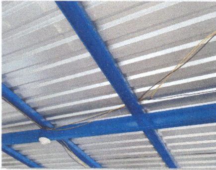
Colicacion de Laminas y costaneras
