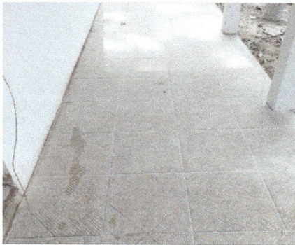
piso ceramico del corredor de la cocina
