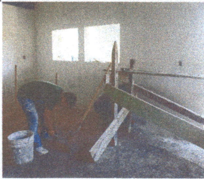
Colocacion de base para el piso ceramico
