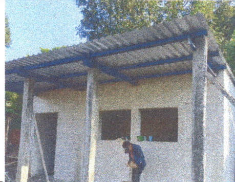
Acabados de paredes
