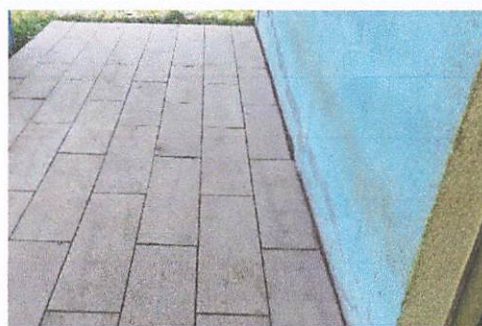
FOTO 4: POSTERIOR CORREDOR DE COCINA CON PISO
